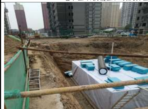
2#雨水调蓄池施工（2022年8月16日）
