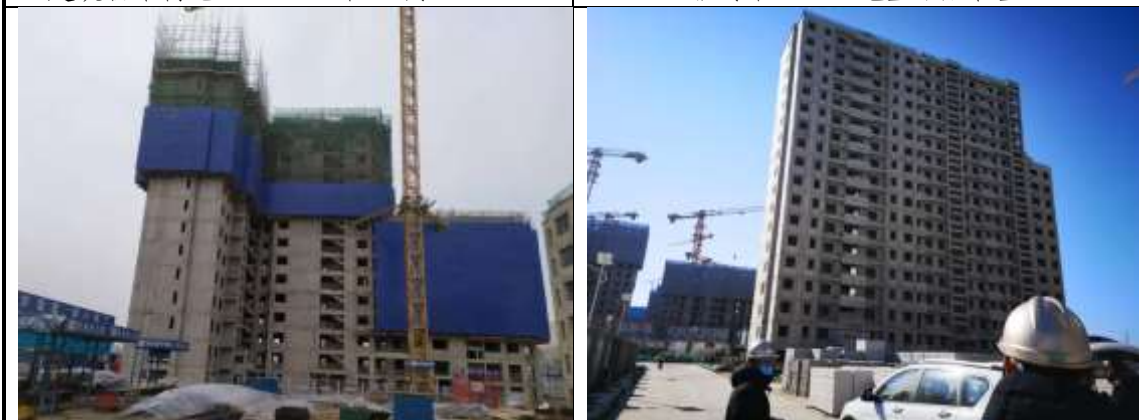
建筑物结构施工（2022年1月18日）
