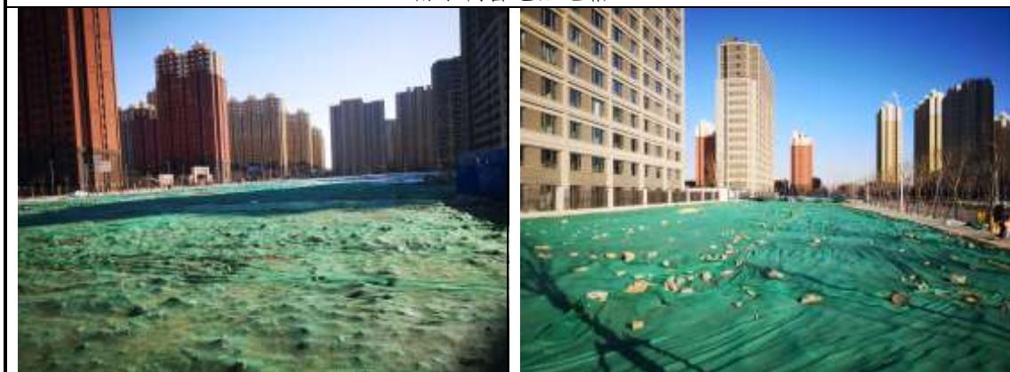
施工临建区土地整治后苫盖
