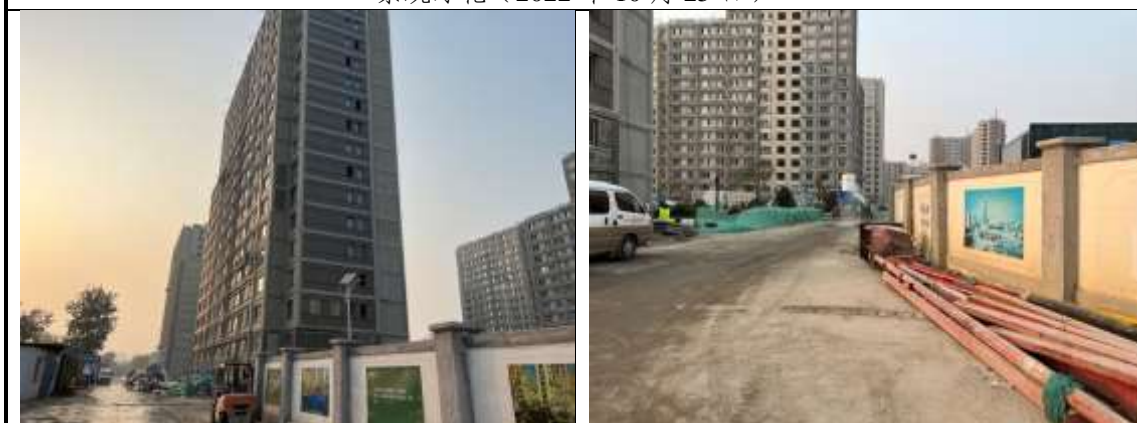
主体建筑物装修（2022年11月）
