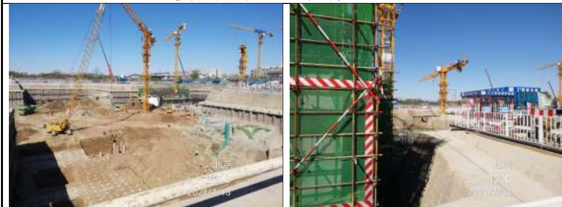
主体工程进展: 基坑开挖及建筑物结构施工 (2021年4月13日)
