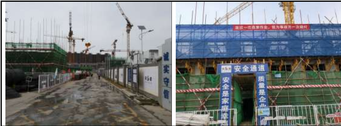
主体工程进展：建筑物结构施工（2021年6月22日）
