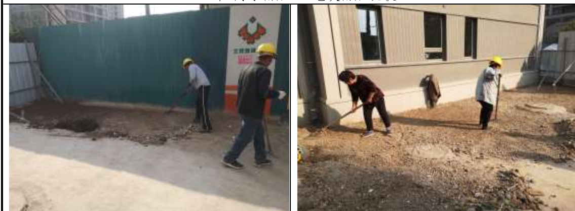
022 地块绿化工程区人工整地 (2023 年 9 月 21 日)
