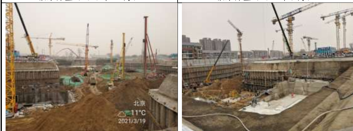
基坑土方开挖 (2021年3月19日)
