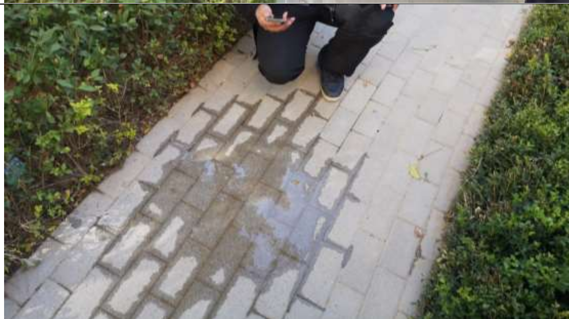
透水砖铺装透水性检验
