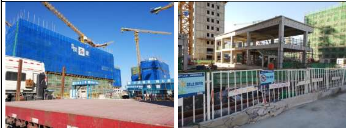
建筑物结构施工（2021年8月17日）
