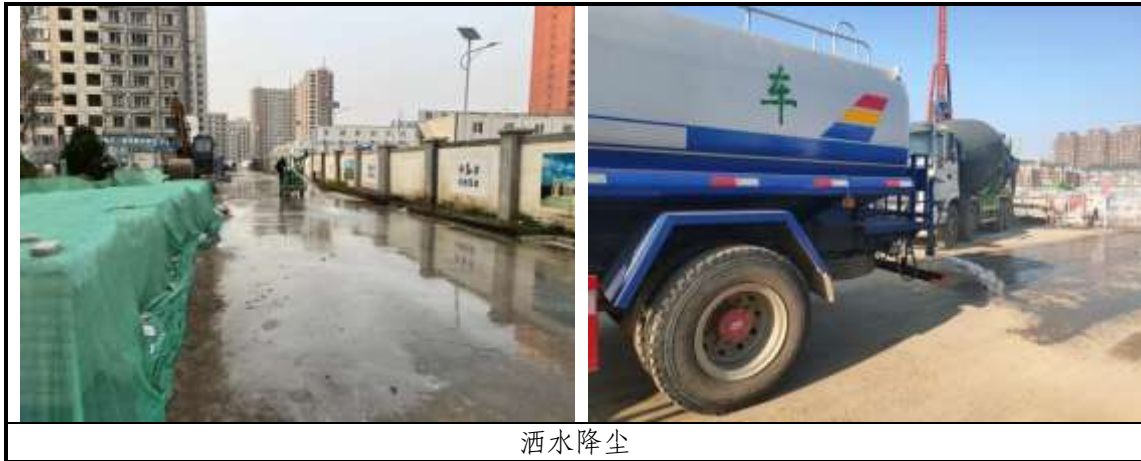
图 4-3 临时防治措施拍摄图
