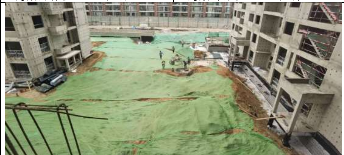
地下室顶板覆土回填及防尘网苫盖（2022年7月12日）
