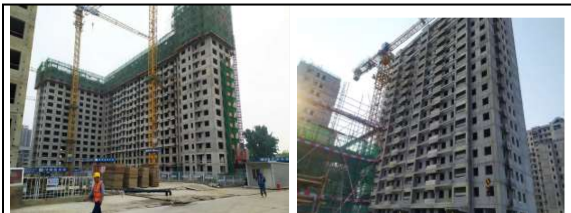
建筑物结构施工（2022年4月25日）
