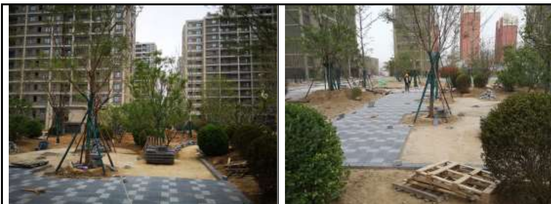
铺装及绿化施工（2023年5月11日）
