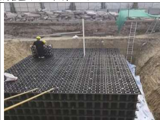
1#雨水调蓄池施工（2022年8月16日）
