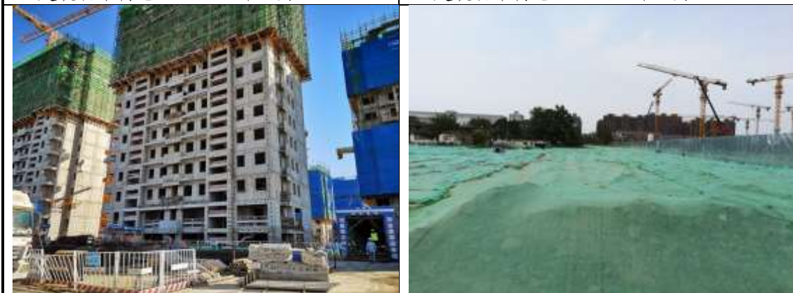
建筑物结构施工（2021年11月16日）
