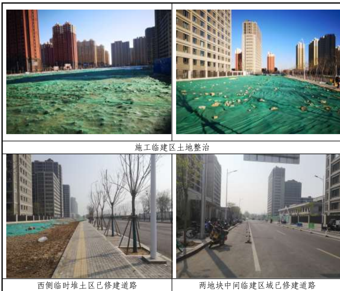
图 3-1 工程措施实施照片
