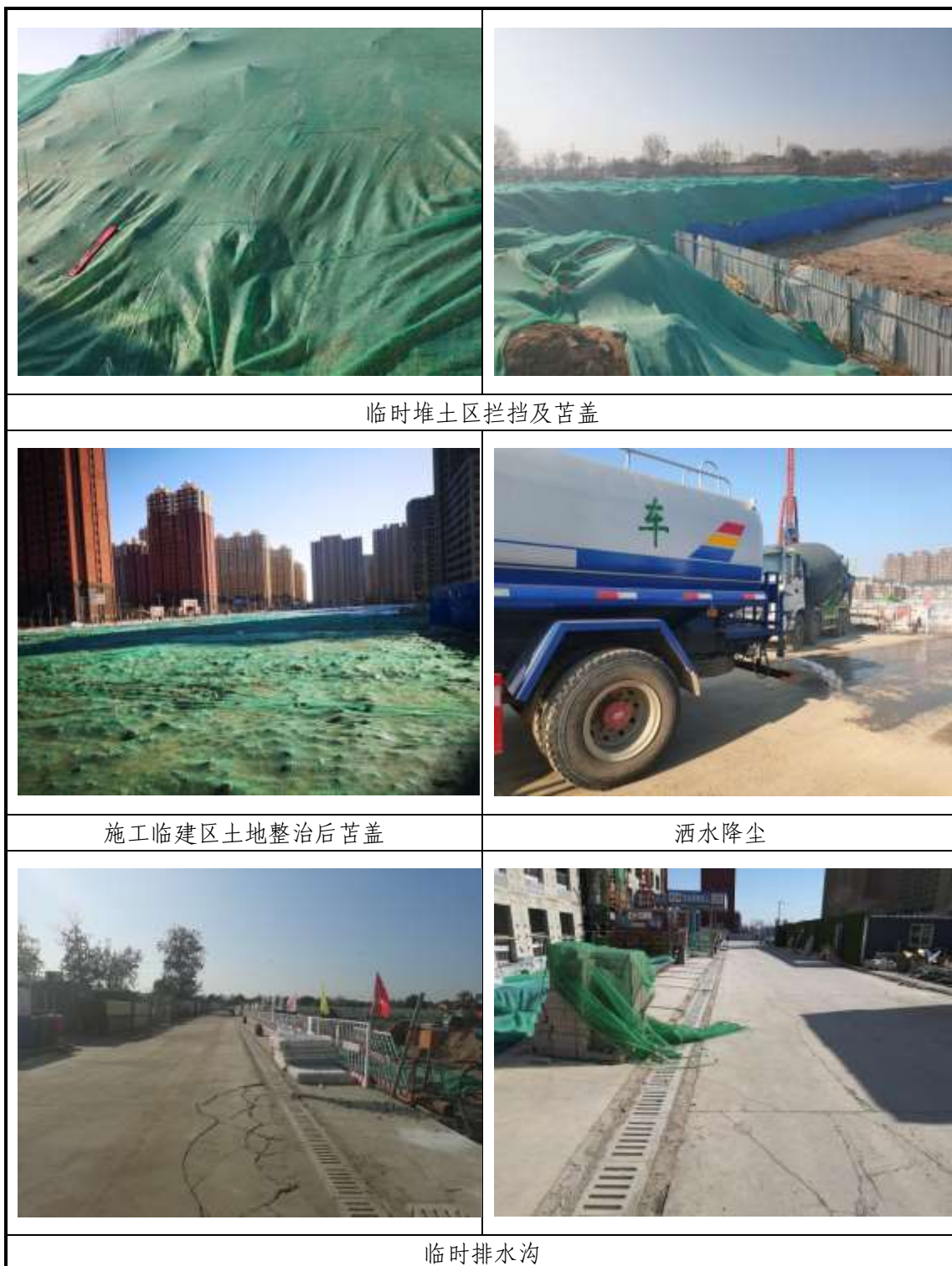
图 3-4 施工现场临时措施实施情况照片
