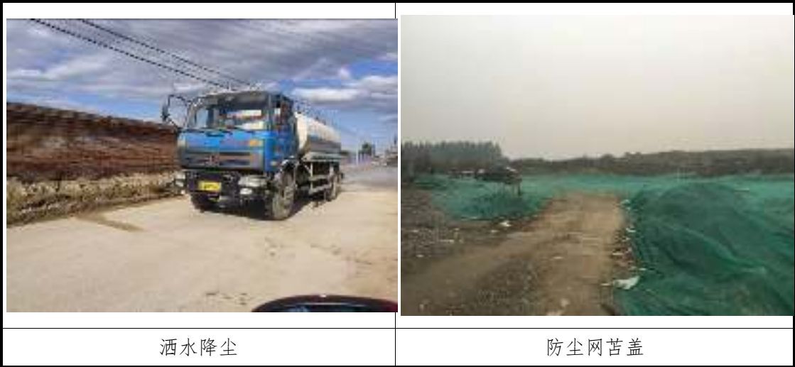
图 3-3 施工过程中临时措施照片
